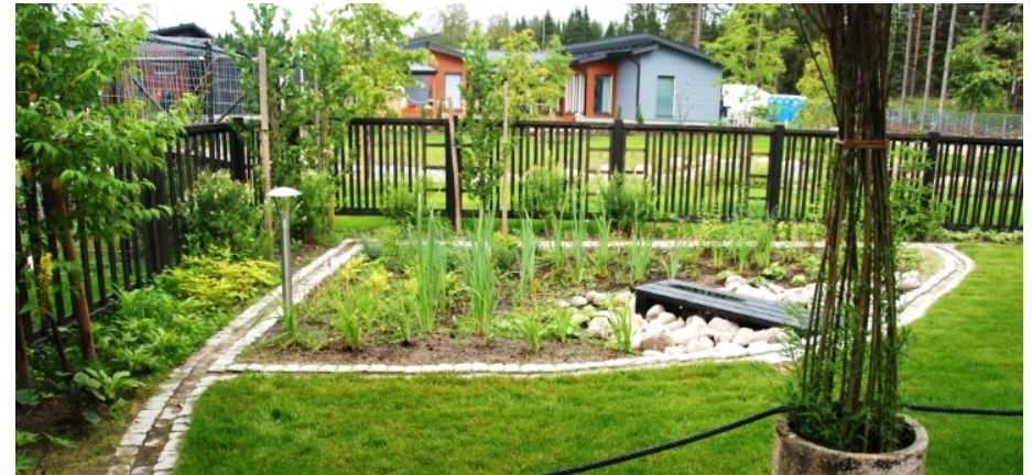
Hulevesien käsittelyalue sadepuutarhassa.
